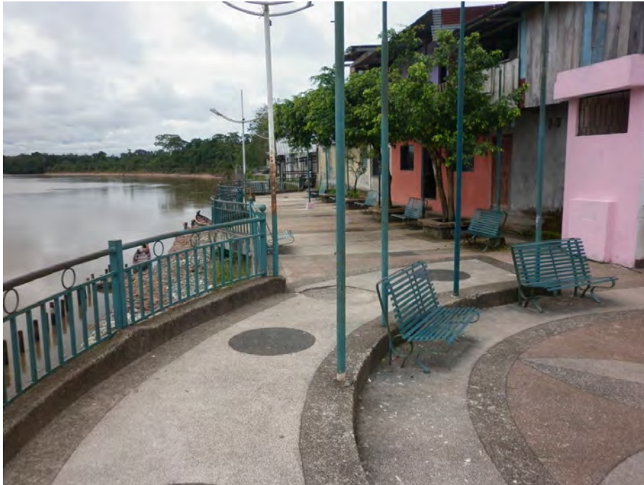
Muro Contención y Muelle en General Farfán
