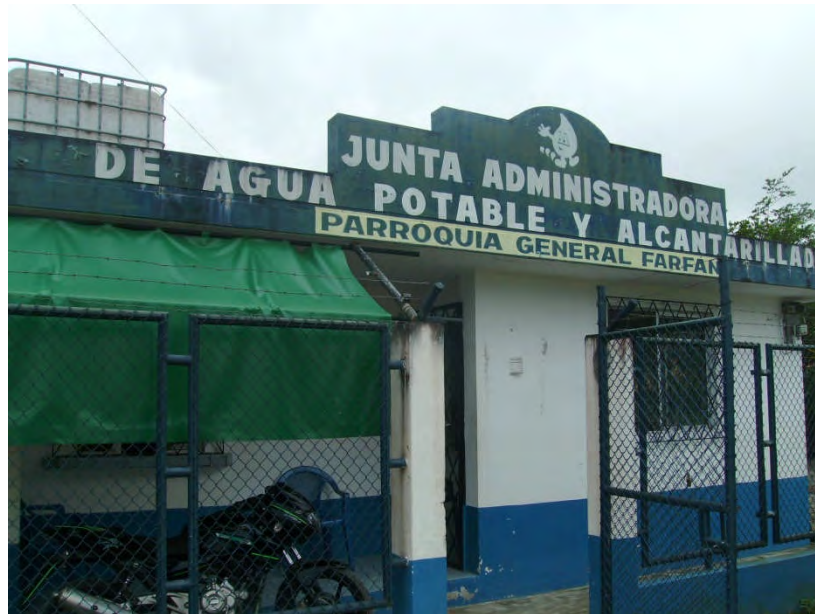
Junta Administradora de Agua y Planta de Tratamiento General Farfán
