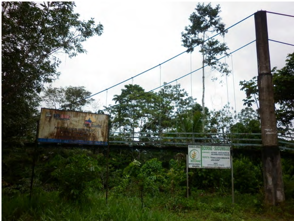
Puente sobre el Rio Conejo en San Francisco
