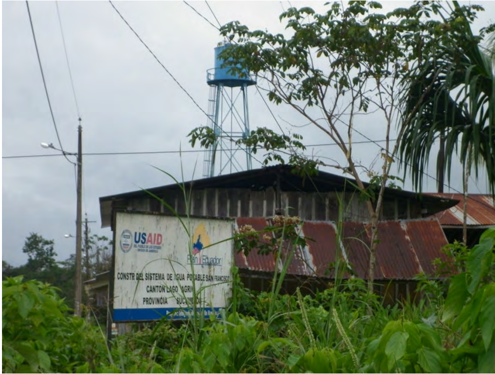
Sistema de Agua Potable en San Francisco
