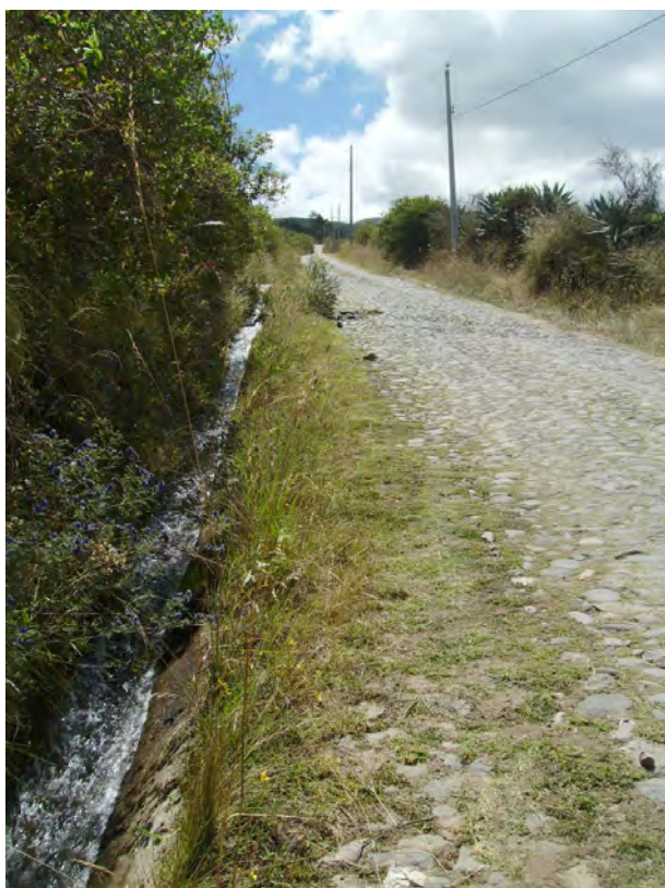
Empedrado al reservorio y revestimiento de canal de riego
